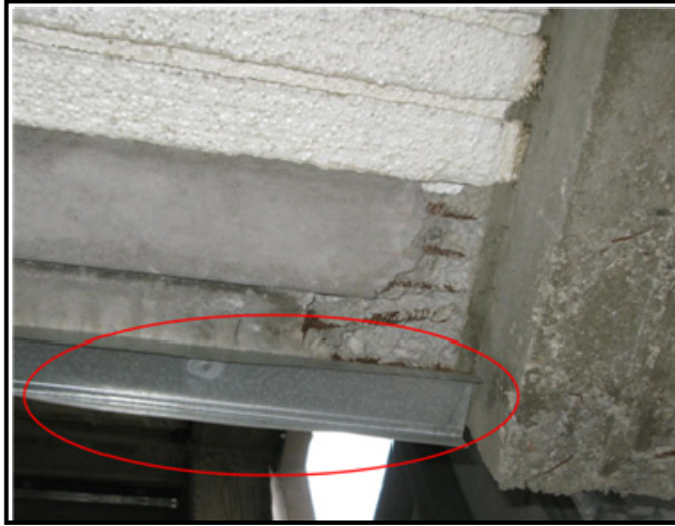
اتصال قاب های کناف به تیرها بدون استفاده از پلیت و بعد از بتن‌ریزی
