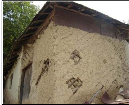
نمایی از یک خانه لاردهای بسیار قدیمی که هنوز استفاده می شود. چوب های قرار داده شده به صورت اریب که ویژگی
