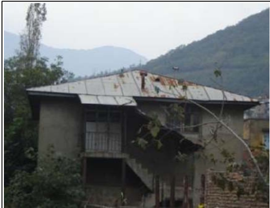
نمایی از یک ساختمان سازمانی قدیمی راه آهن که برای زندگی کارکنانش بوده و در حوالی ایستگاه نیز قرار دارد.
