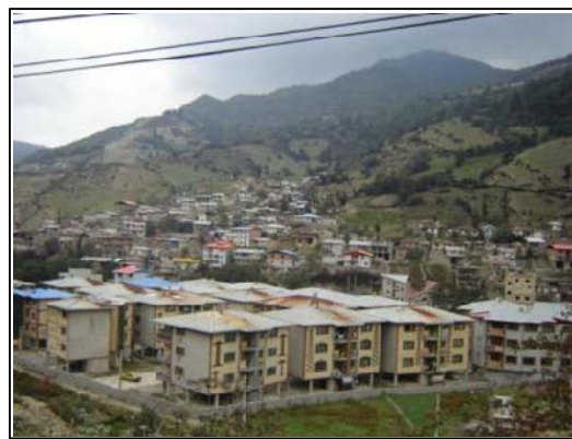
نمایی از شهرک فرهنگیان که یکی از اولین نمونه های انبوه سازی در پل سفید بوده است.
