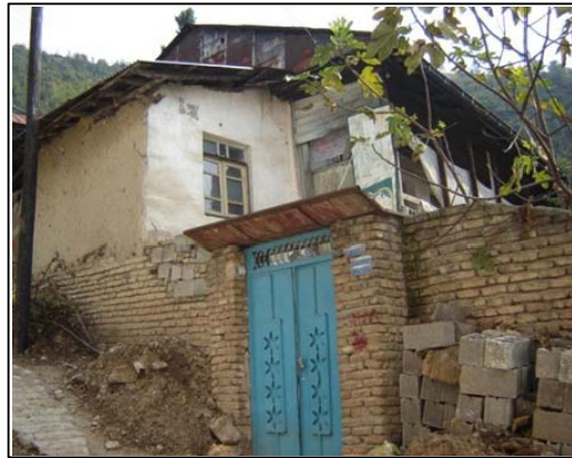
ساختمان لارده‌ای محوطه‌سازی شده با آجر، دیوار آجری وصله شده با بلوک‌های سیمانی و نیز تجمع بلوک‌ها در جلوی در که به معنای ادامه داشتن روند مرمت است.
