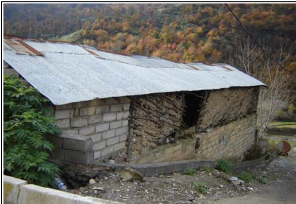
نمایی از یک خانه لارده‌ای که حلب سقف آن تعویض شده و با بلوک سیمانی در مجاورتش فضای جدیدی ساخته‌اند.
