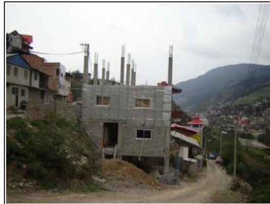
نمایی از ساختمان بتنی چندطبقه در حال ساخت در شهر
